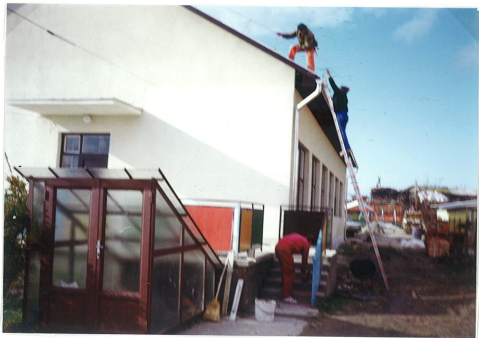
Villámhártyót szerelnek a tetőre.
